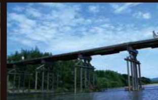
上津屋橋 (流橋)
